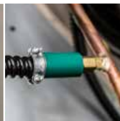
Control de alta presión
